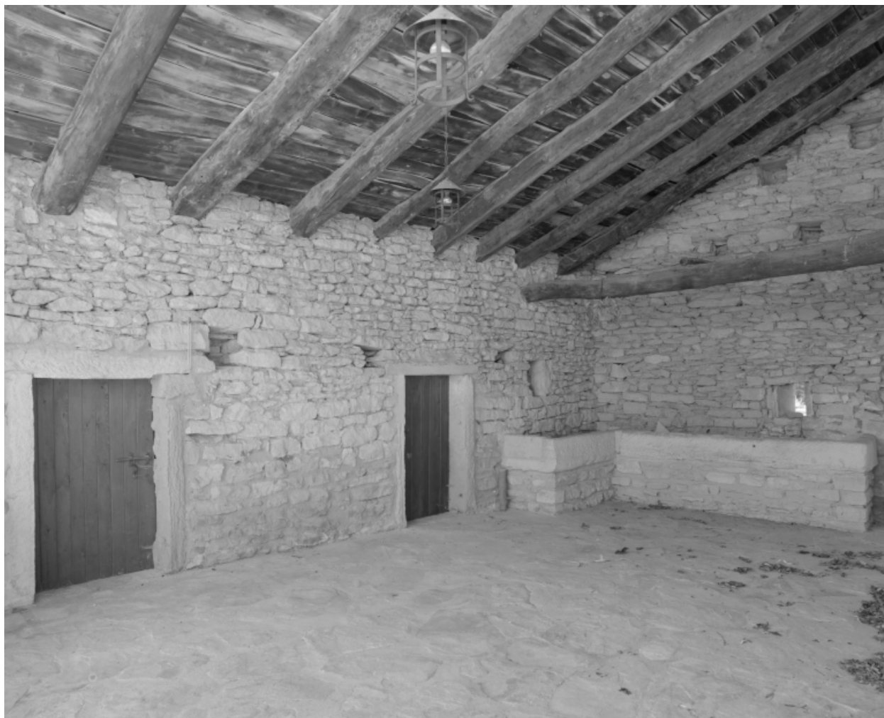
La Garrigue. Intérieur du hangar.
