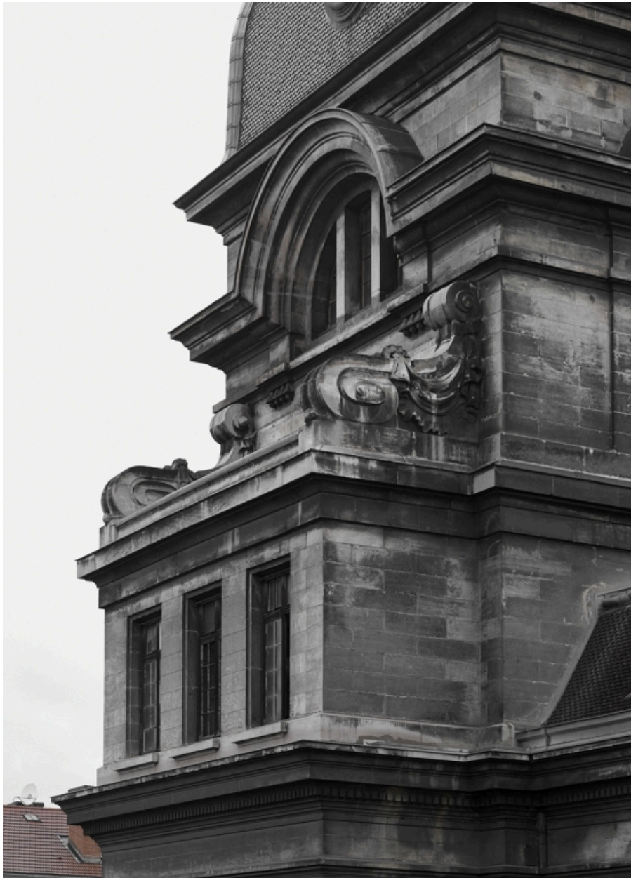
Le dôme Pascalon. Détail de la façade sud
