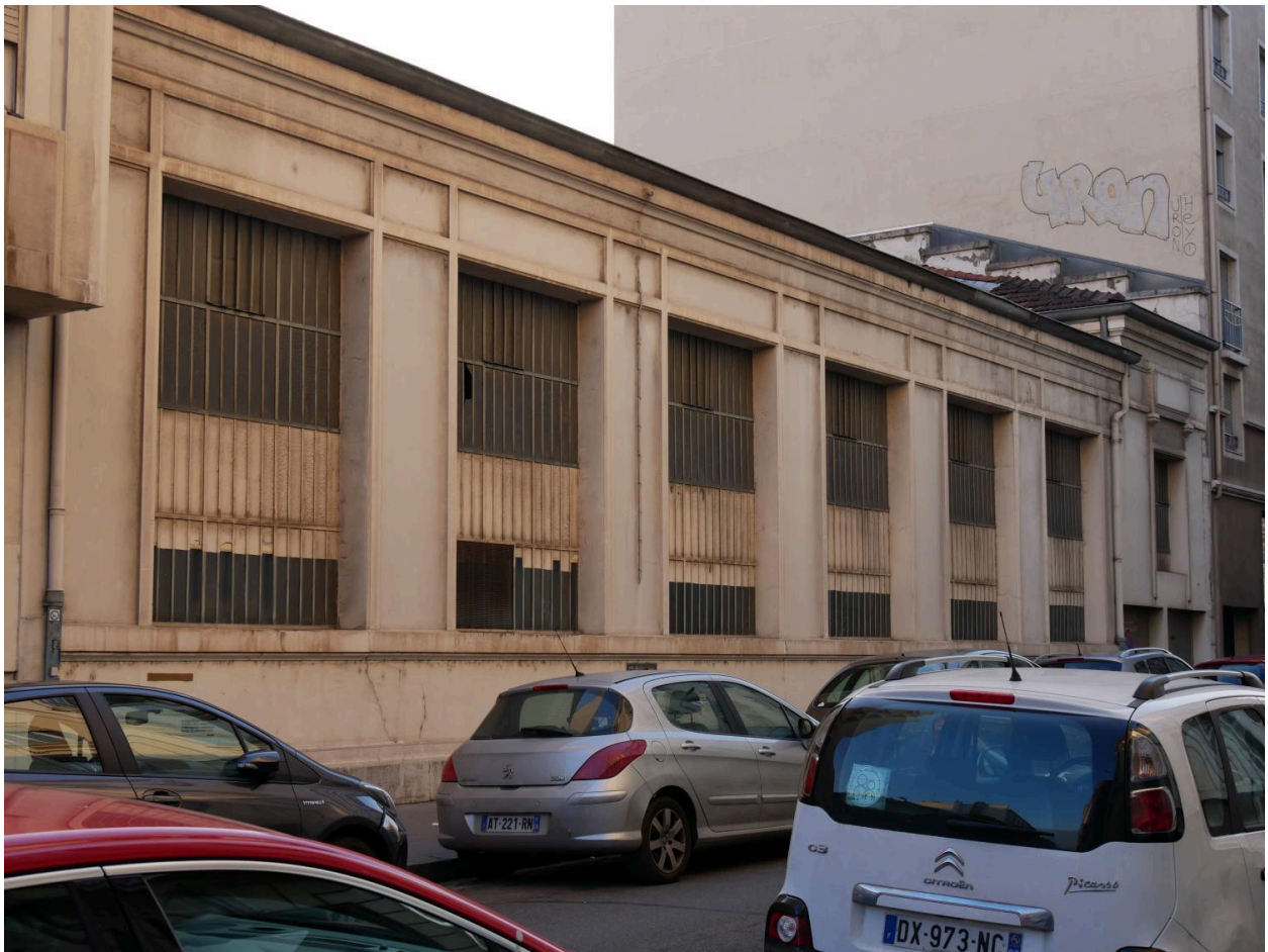
façade nord rue Etienne Rognon
