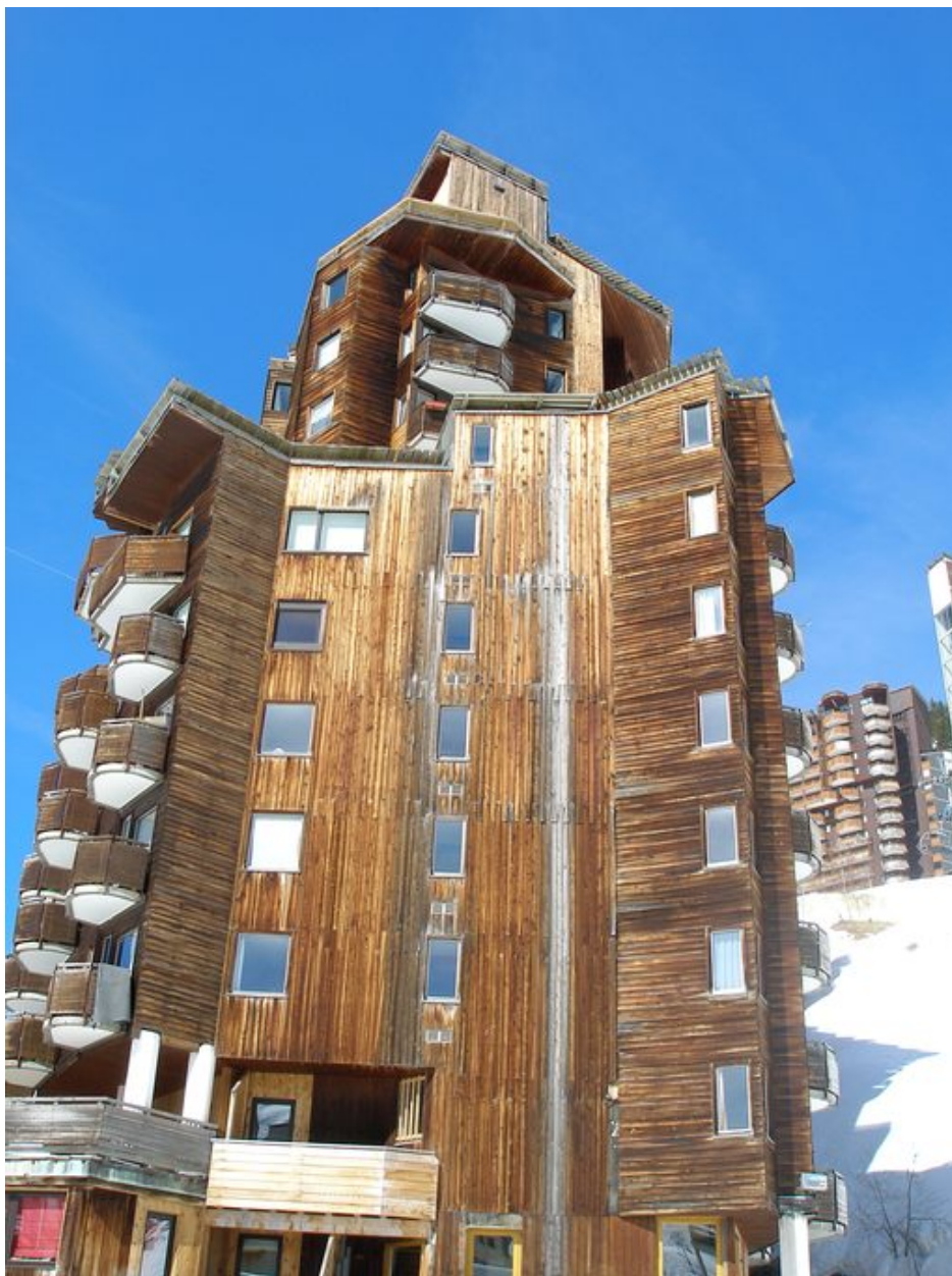
Le pignon aval, au sud
