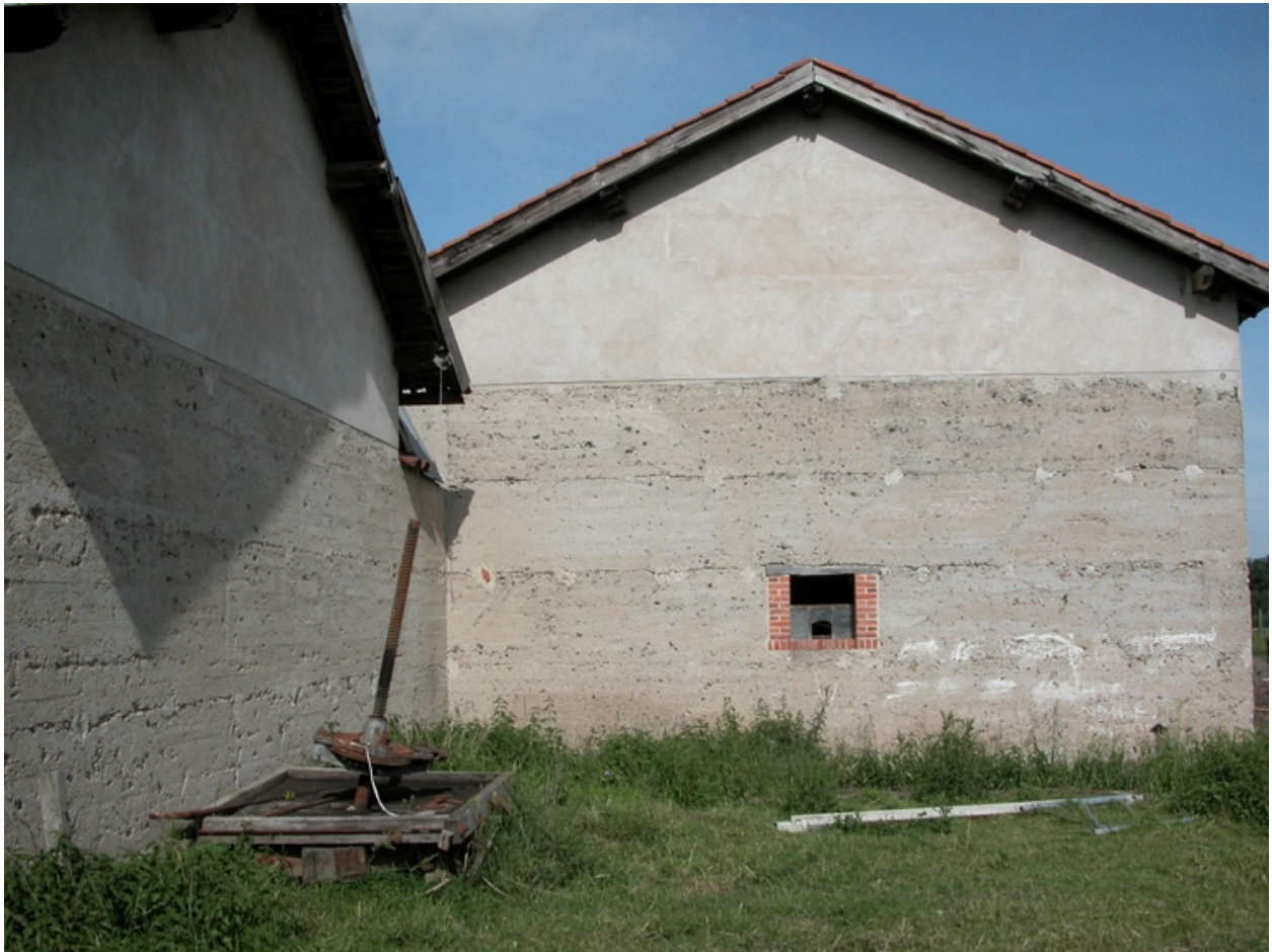
Vue arrière de l'angle entre l'étable et le hangar, avec le pressoir.
