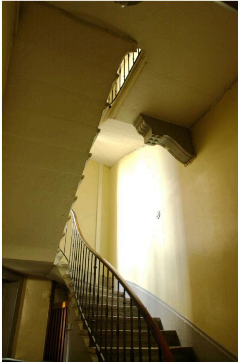
Vue de la cage d'escalier et du palier soutenu par une console
