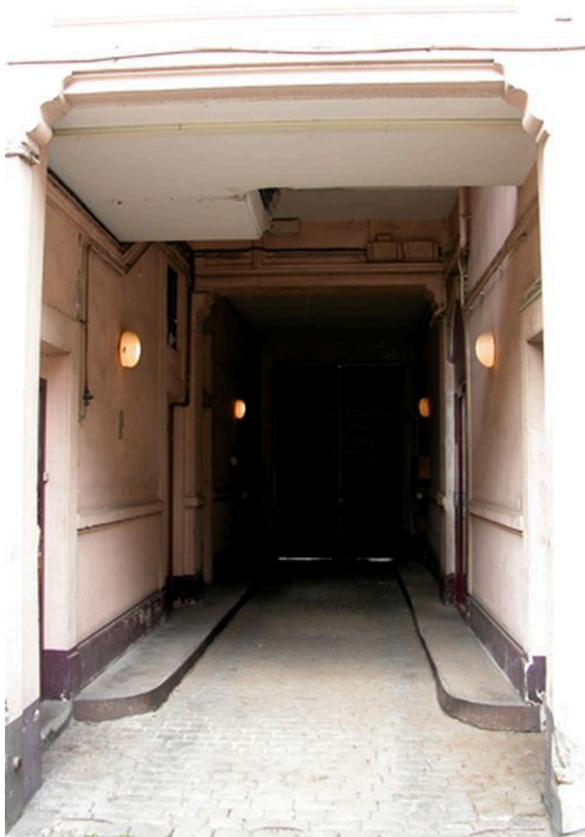
Vue du passage couvert depuis la cour
