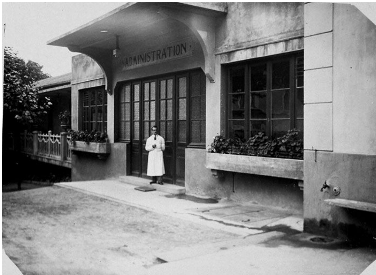
Pavillon administratif de l'hôpital de l'Antiquaille [23]. Bureaux et réception des malades, photogr. ca 1935
