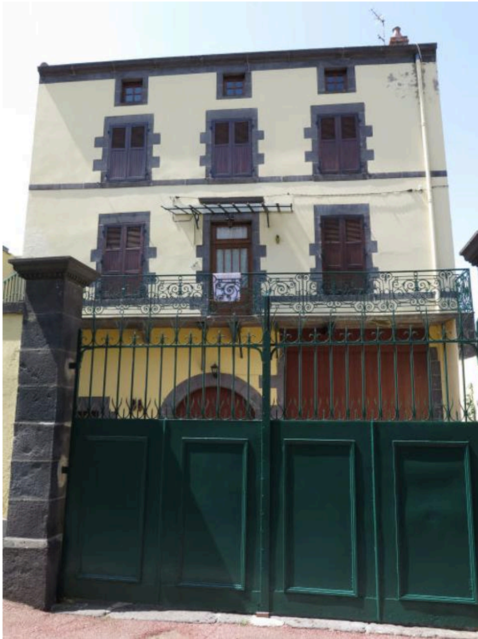
Vue générale de la façade principale
