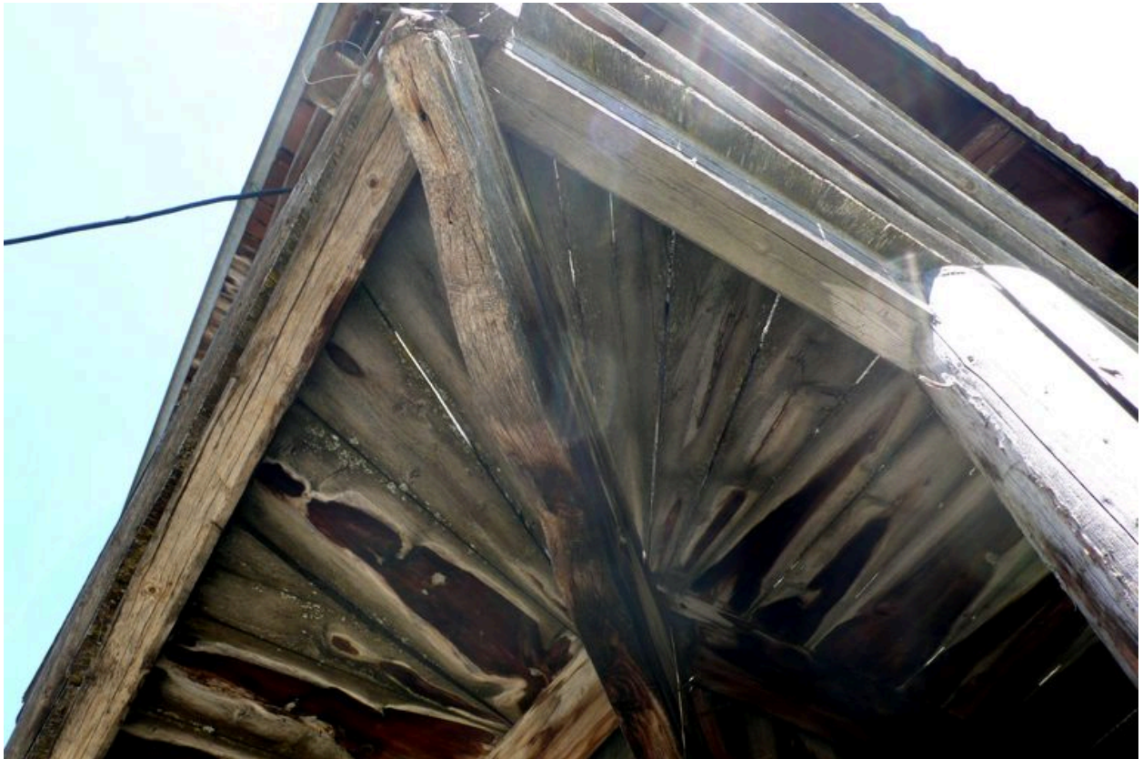
Hameau du Pleney. Remise à bois. Détail de l'avant-toit
