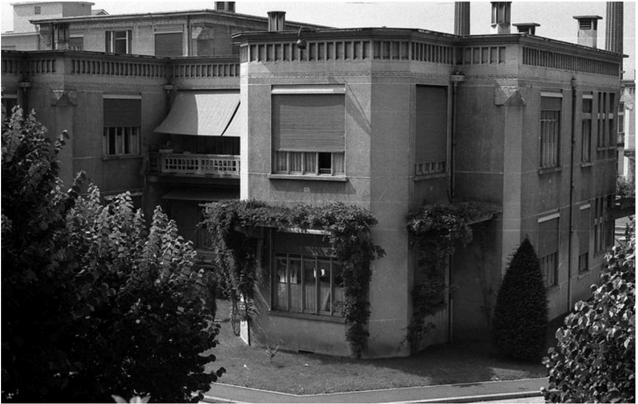
Pavillon N Nbis. Vue d'ensemble des ailes orientales depuis le sud-est. Photogr., après 1970
