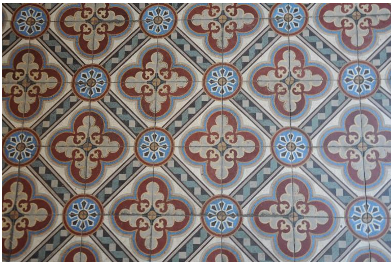
Sol en carreaux de ciment
