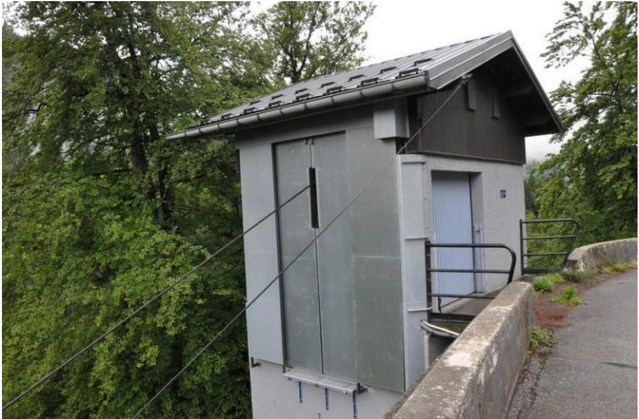
Bâtiment situé au bord de la route départementale. Il est relié au barrage des Mottets par un câble qui permet de descendre du matériel.
