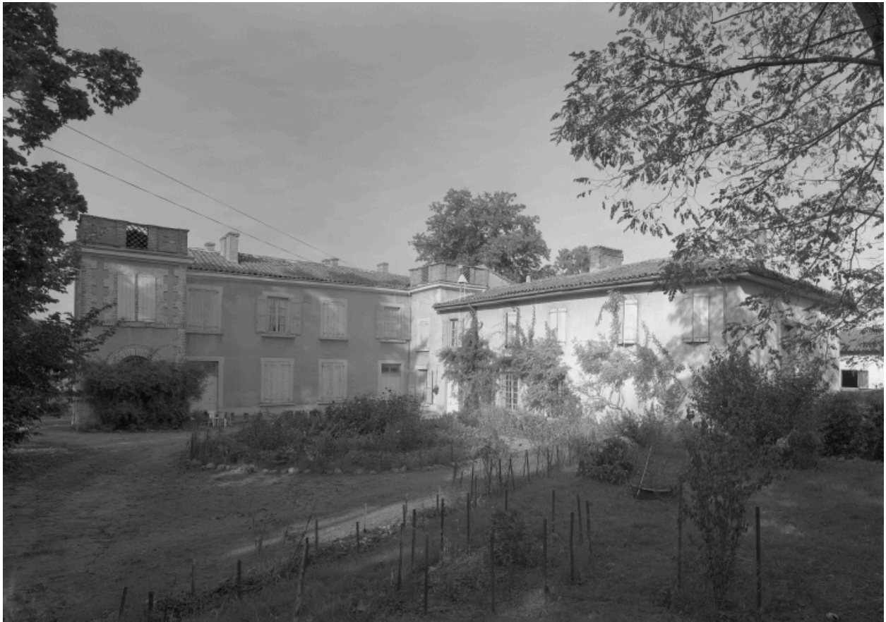
Vue d'ensemble du logis côté cour : façade antérieure du corps de logis du 19e siècle, façade postérieure du corps de logis du 16e siècle.
