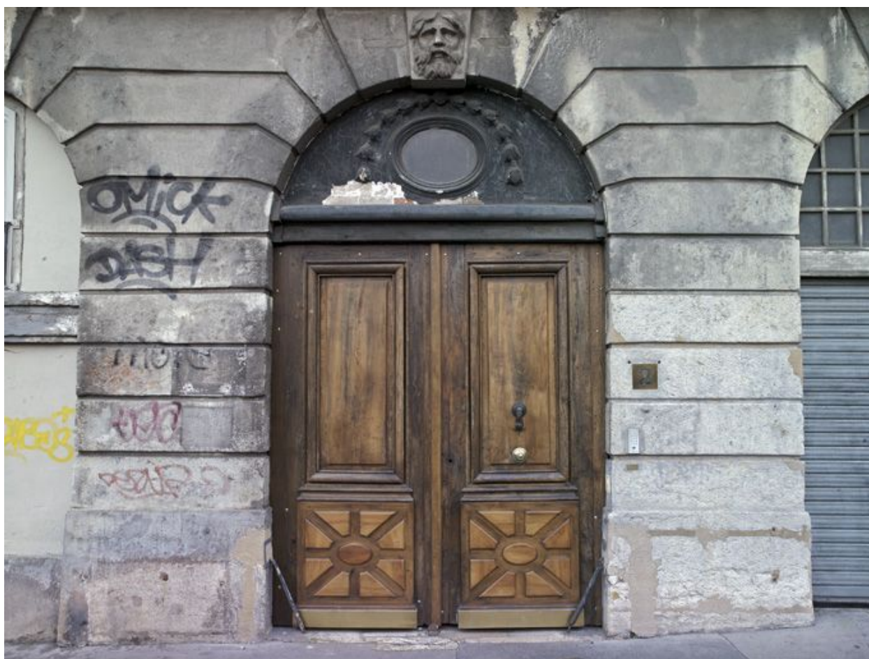
Porte, 2 rue de Provence
