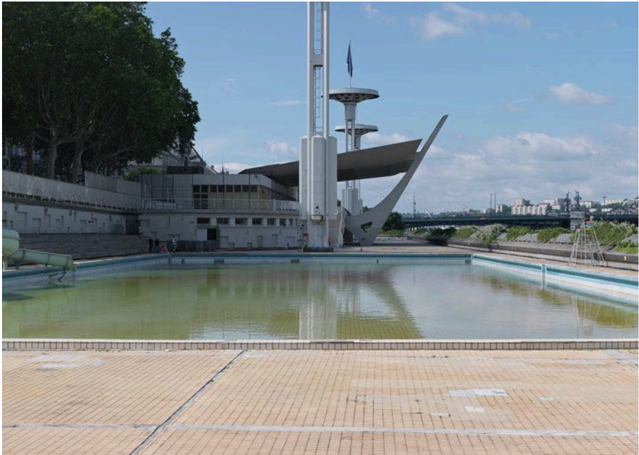
Partie nord de la piscine : le bassin de baignade et le bâtiment d'exploitation (état juin 2012).
