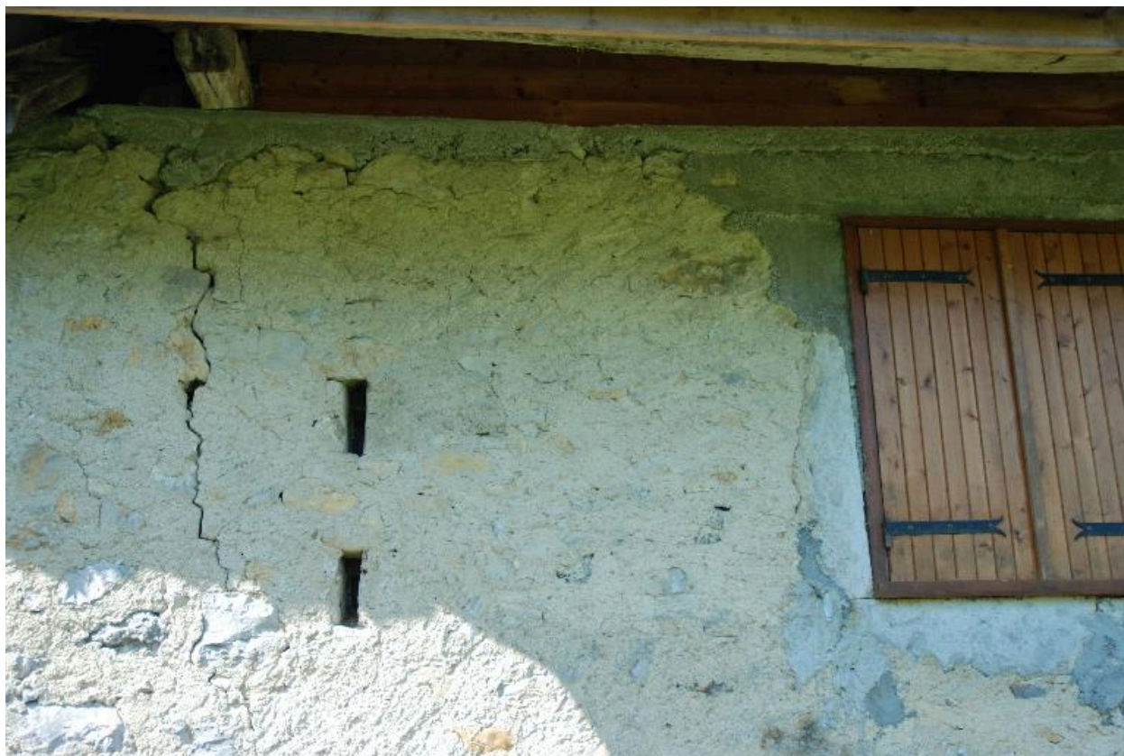
Vue des jours d'aération de placard, en façade arrière.
