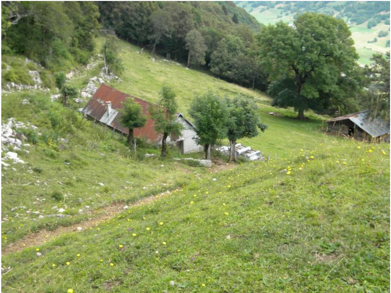
Vue de d'ensemble des bâtiments
