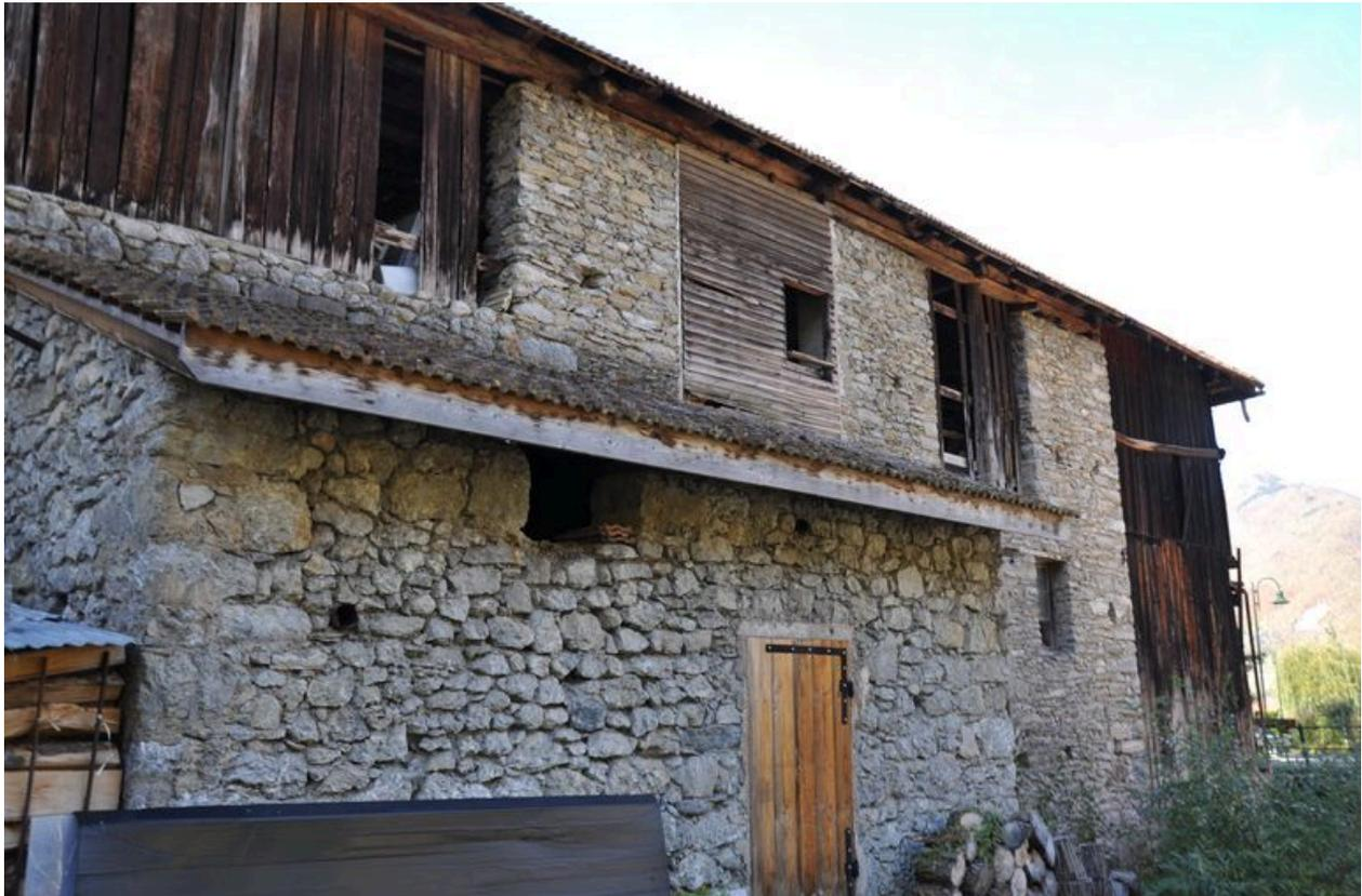
Les abat-vents permettent d'éclairer la scierie à l'étage
