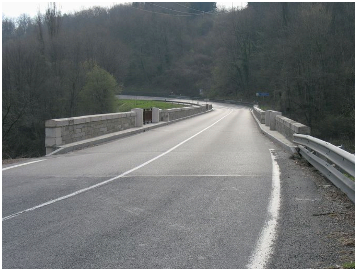
Vue sur le tablier
