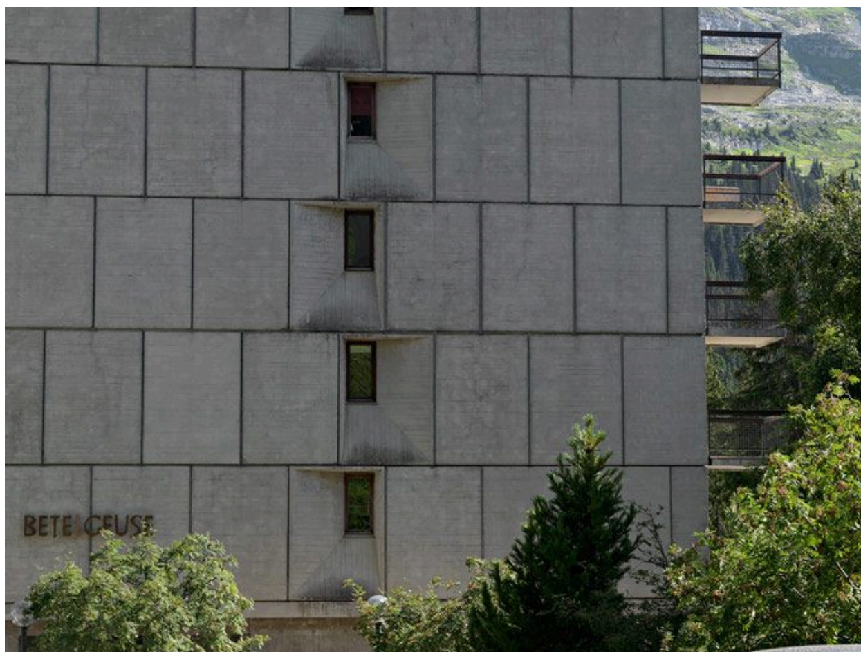
Détail du pignon nord
