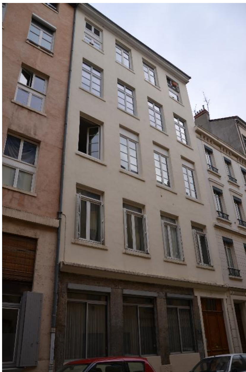
Vue d'ensemble façade sud
