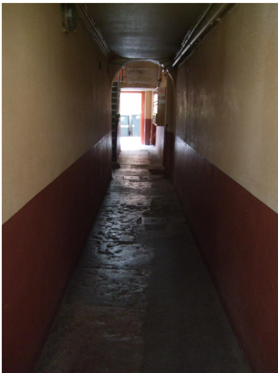
Couloir d'accès à l'escalier
