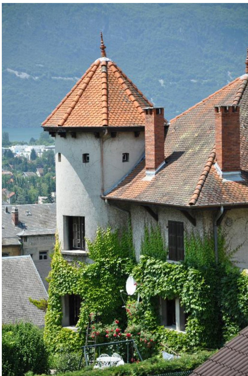
Tour d'angle demi hors-oeuvre
