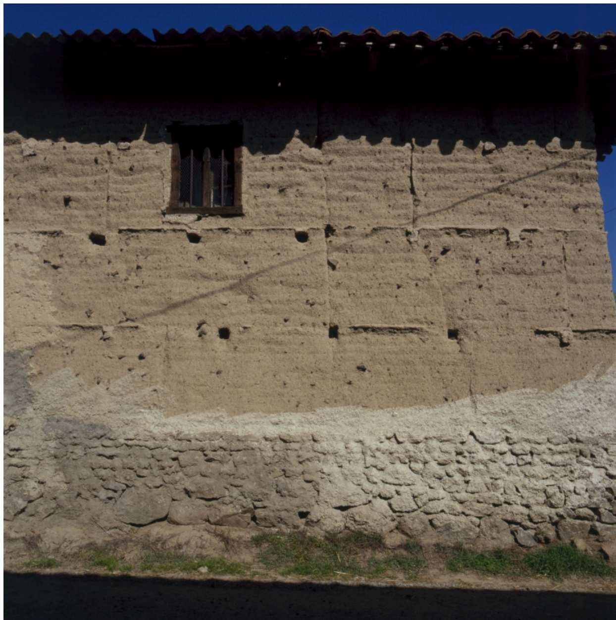
Bussy-Albieux, Gouttebelin (1987 D2 693). Bâtiment est, Façade sud. Détail de mur en pisé à joints verticaux (17e ou 18e siècle ?).
