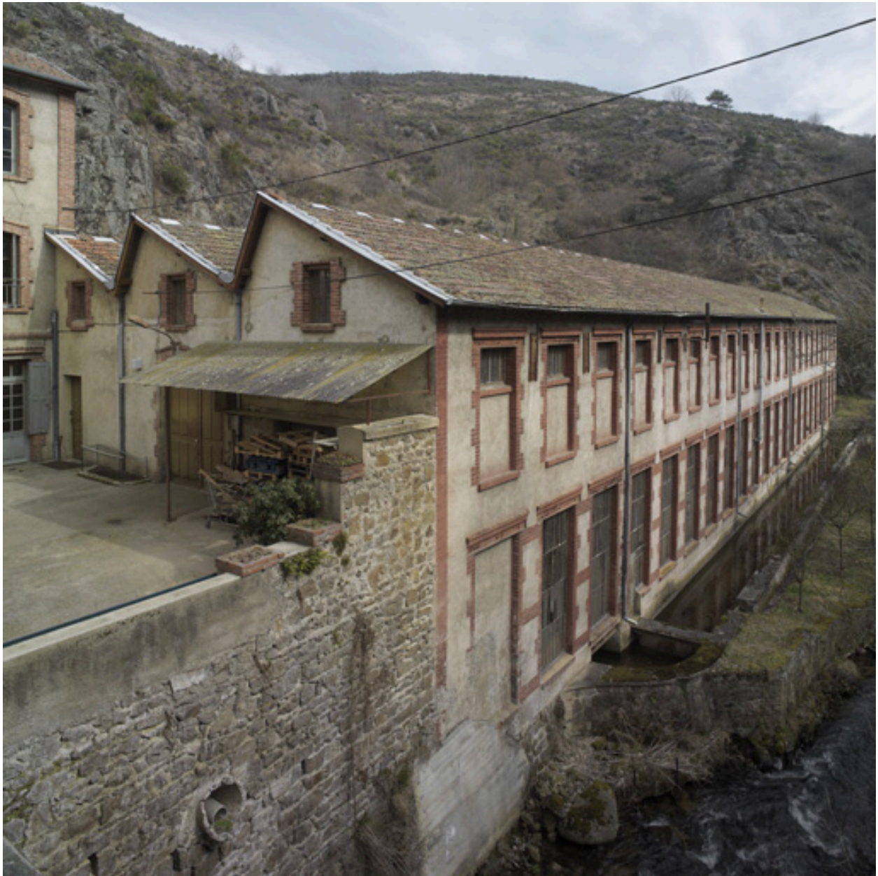
Vue des ateliers, depuis le sud-ouest.
