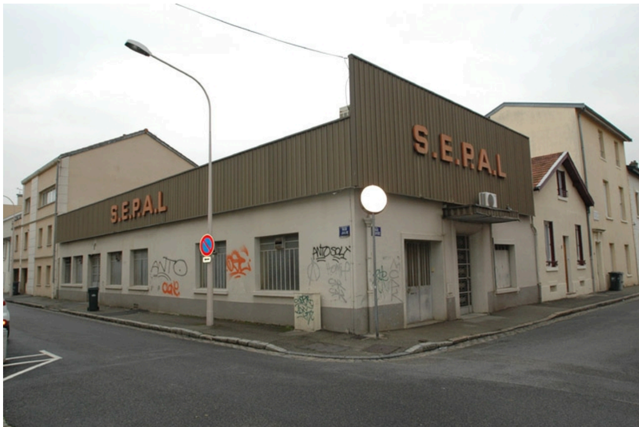
Vue générale, angle nord ouest.
