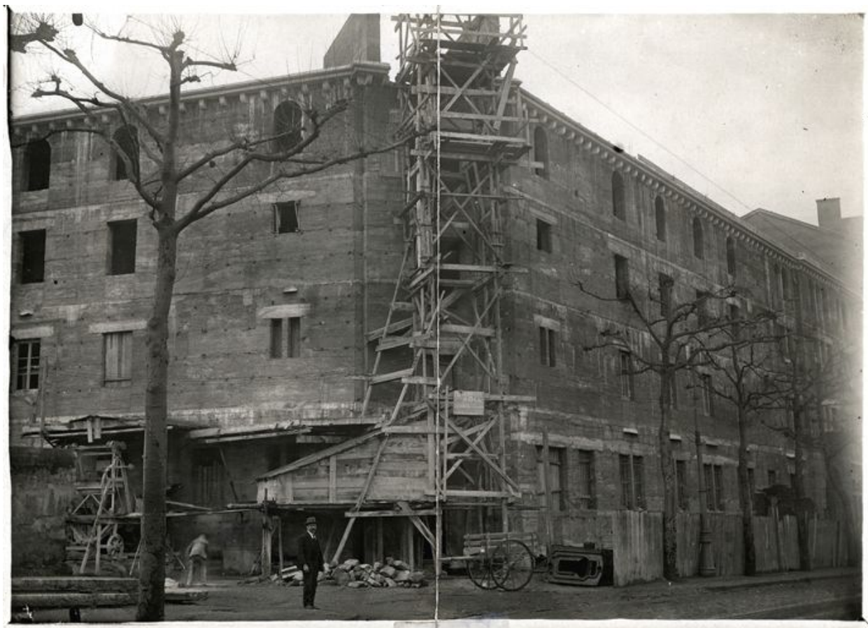
Construction de la maison provinciale, angle rue Robin et cours Gambetta, 1923-1924. Photogr., 1924 (A. Missions africaines)
