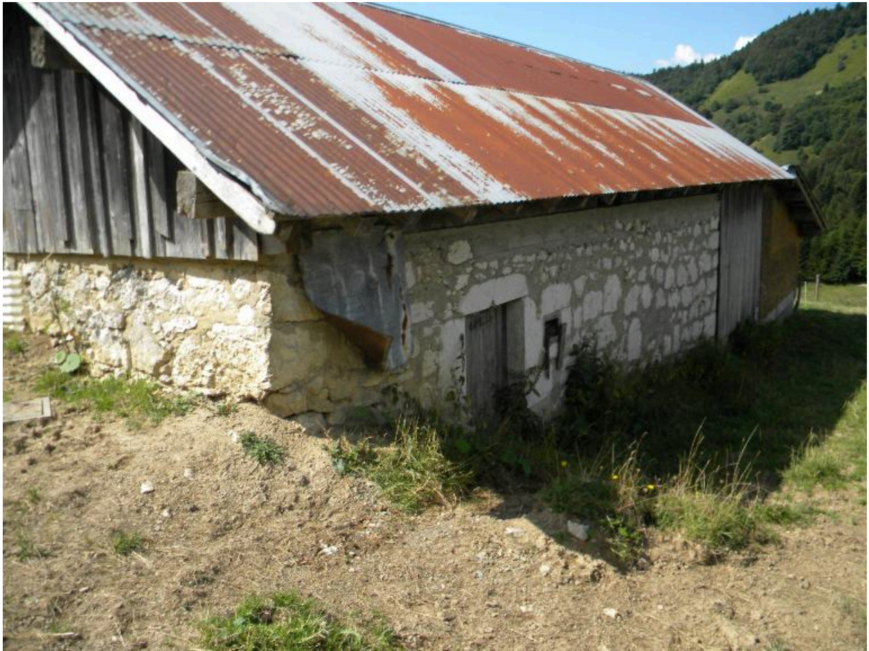
Vue de la façade sud du bâtiment secondaire à l'aval.
