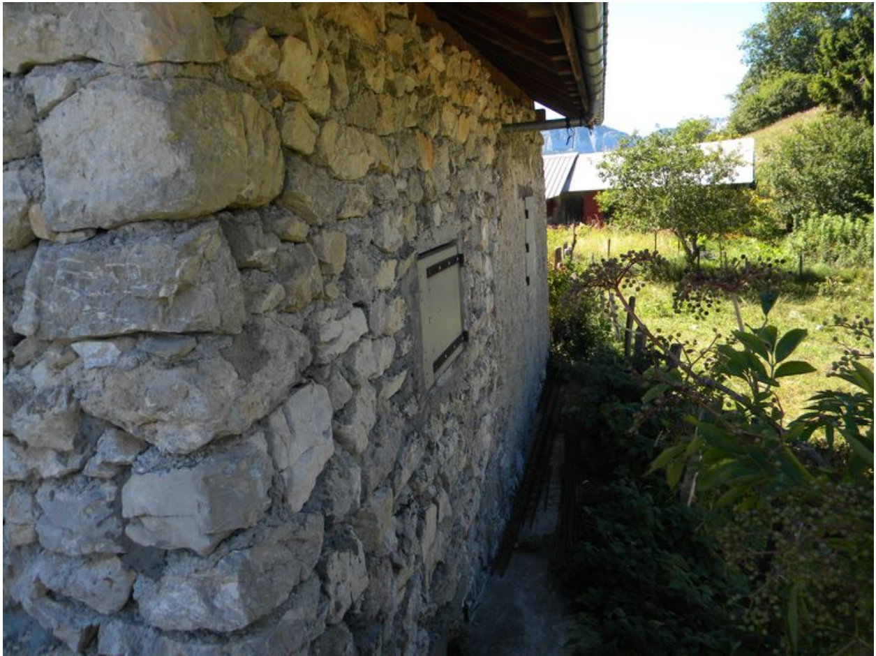
Détail des maçonneries d'une ancienne grange au coeur du hameau.
