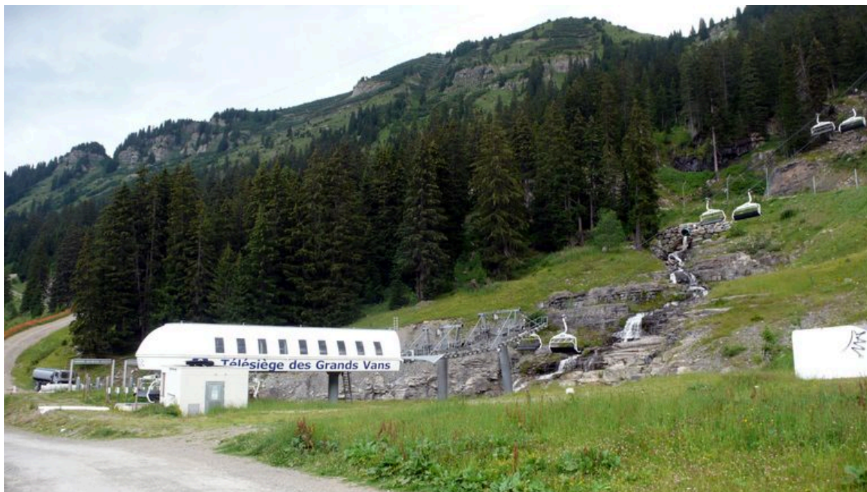
Le télésiège des Grands Vans et le torrent de Flaine
