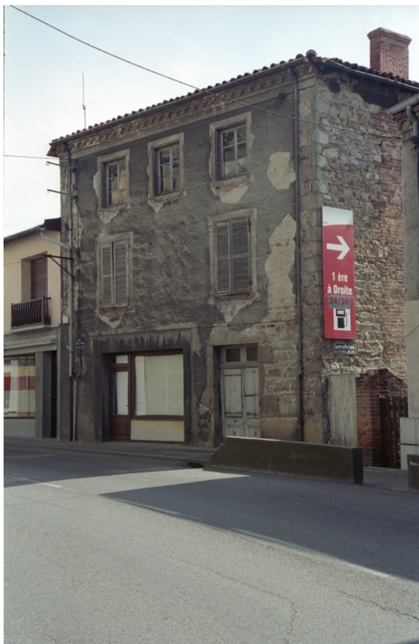
Boën, îlot 18, Lyon (rue de) - parcelle AO13. Vue générale de la façade sur rue.
