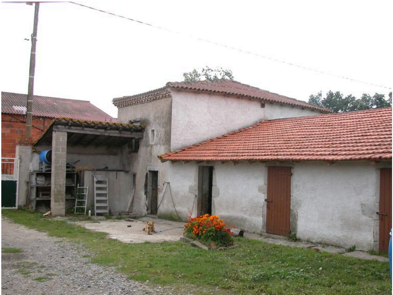
Vue d'ensemble du logis ou logement, du cuvage et de la porcherie.
