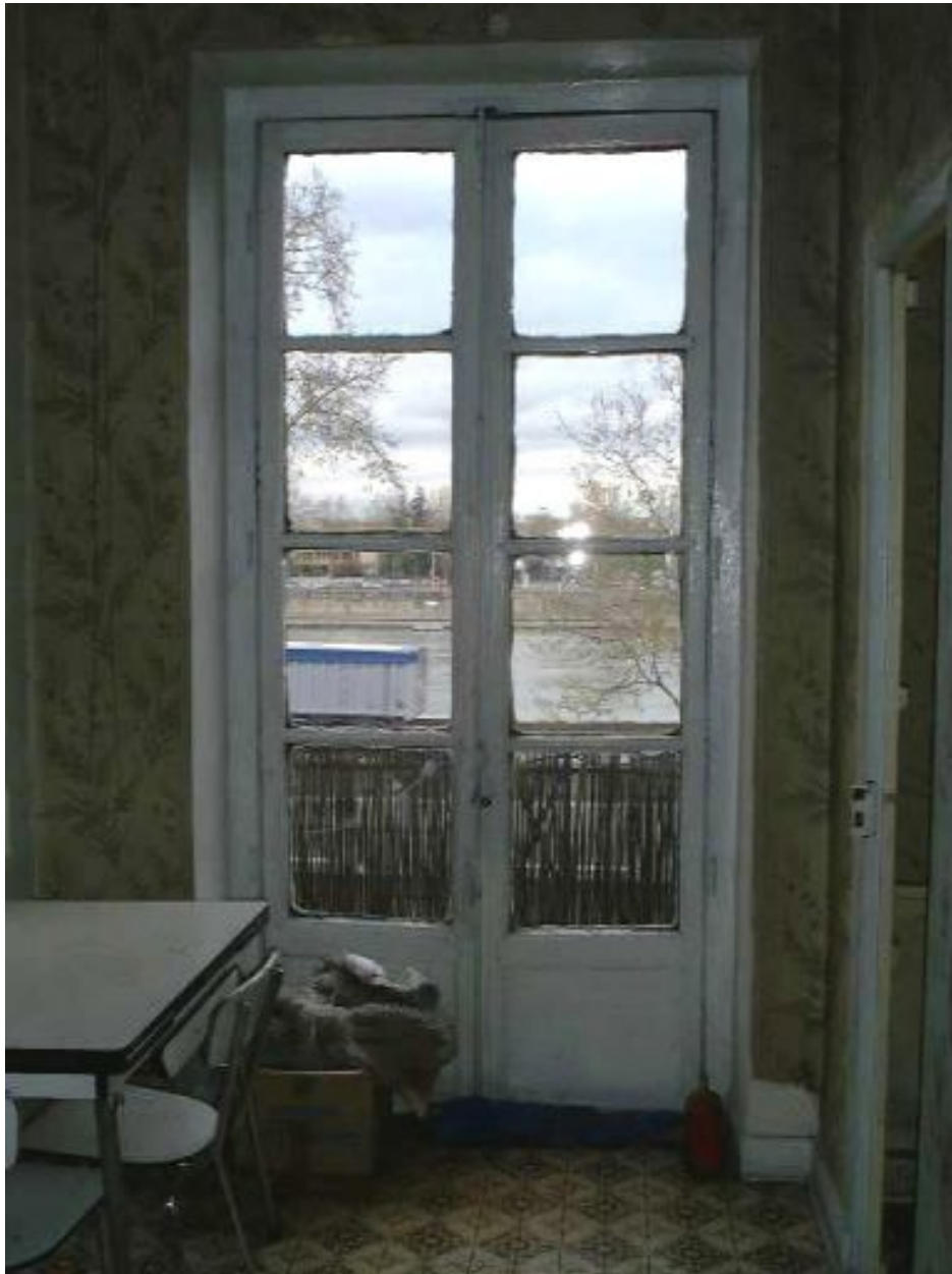
La porte fenêtre ouvrant sur le balcon nord-est
