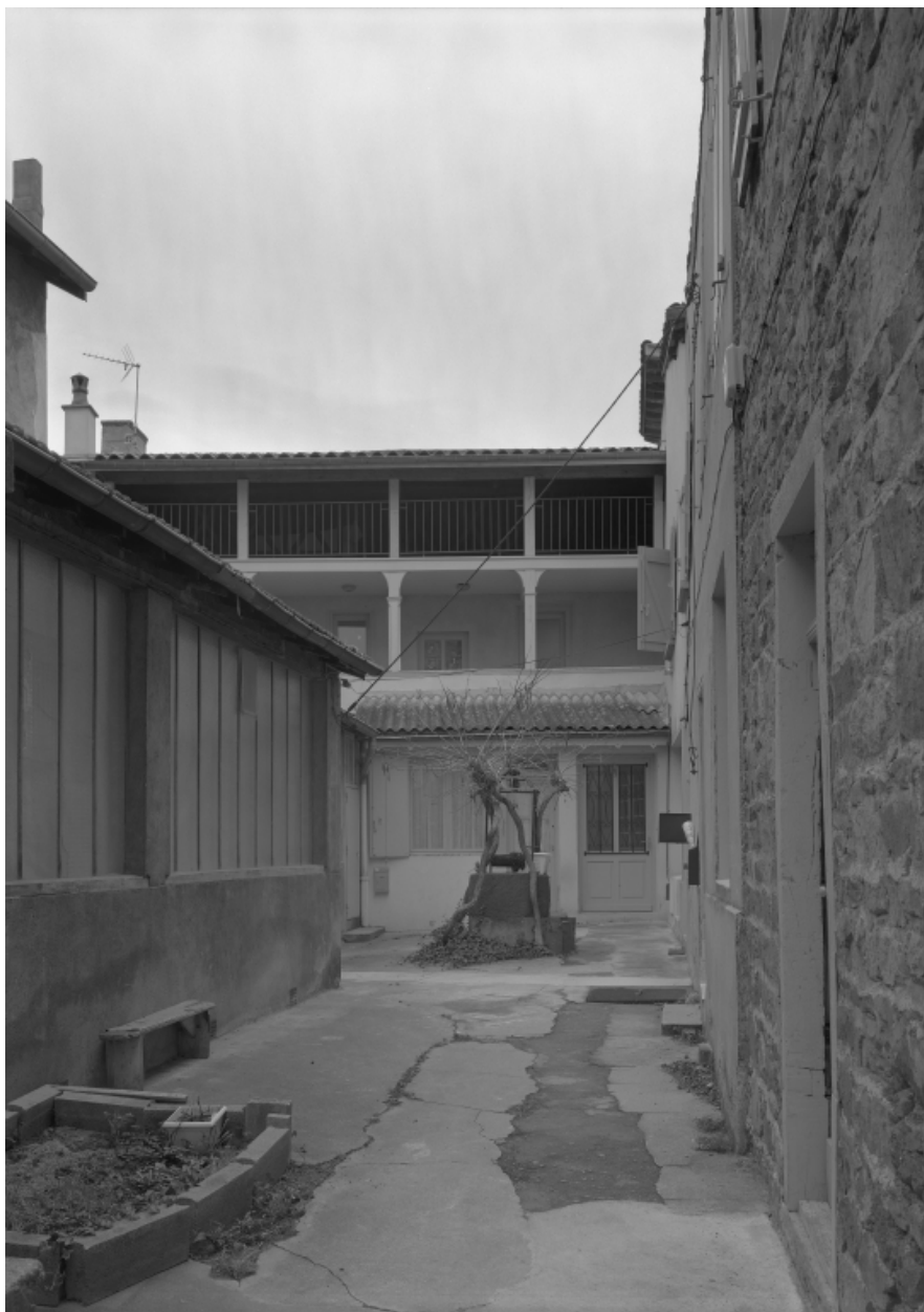
Vue de la façade postérieure à galerie, de l'est.
