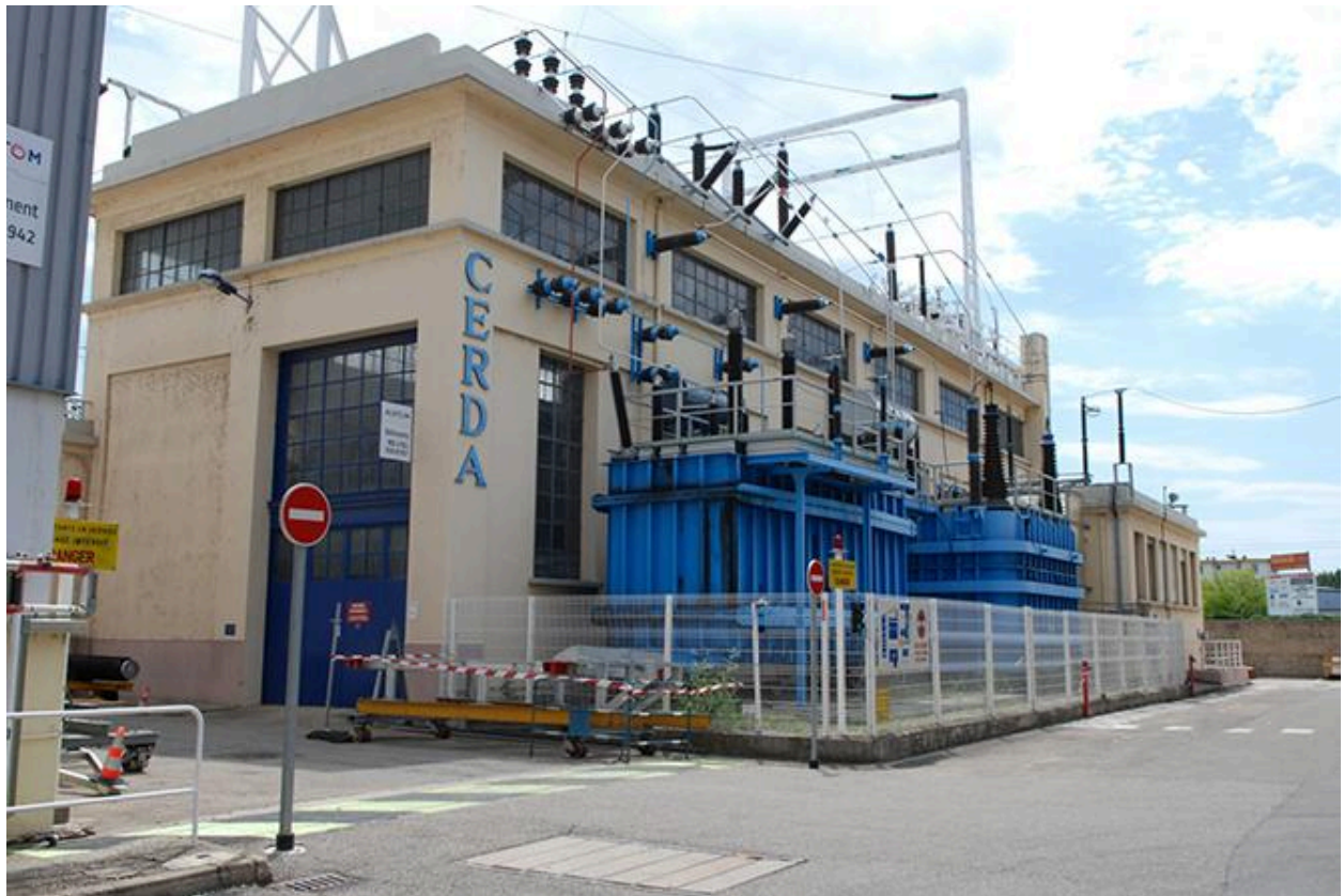
Bâtiment de recherche (centre d'essais) : CERDA
