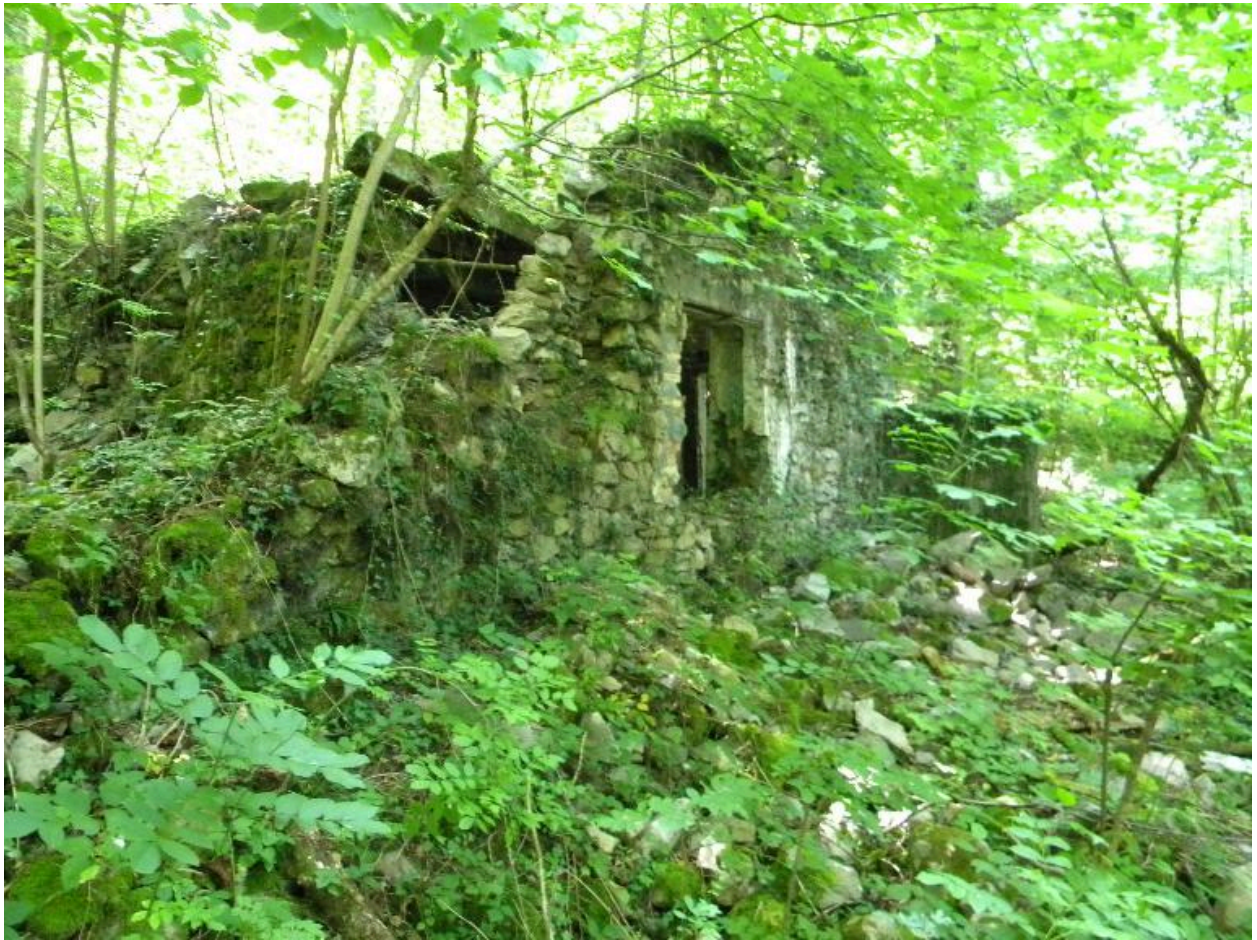
Vestiges d'une maison en bas du hameau (2008 D9 1819).
