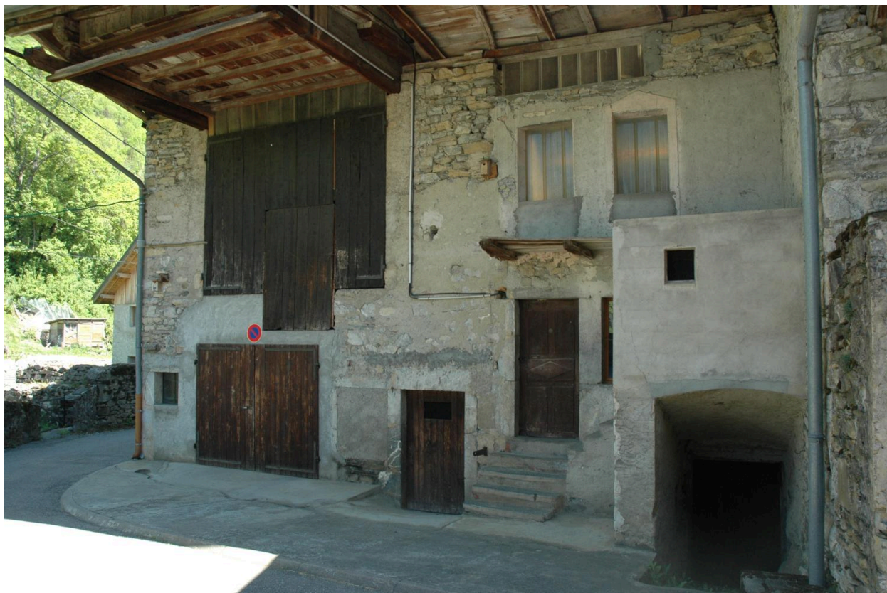
Mont-Benoît. Maison de vigneron et grange-étable (2018 A4 629).
