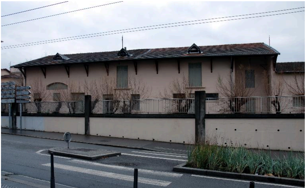
Ancien hangar : élévation sur rue
