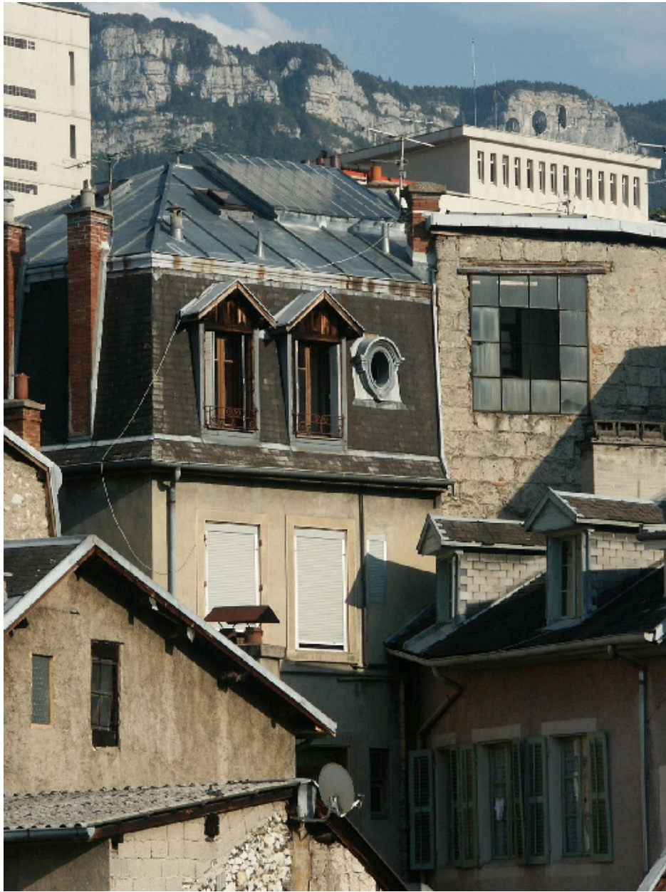
Revers d'immeubles rue Davat et ruelle du Revet
