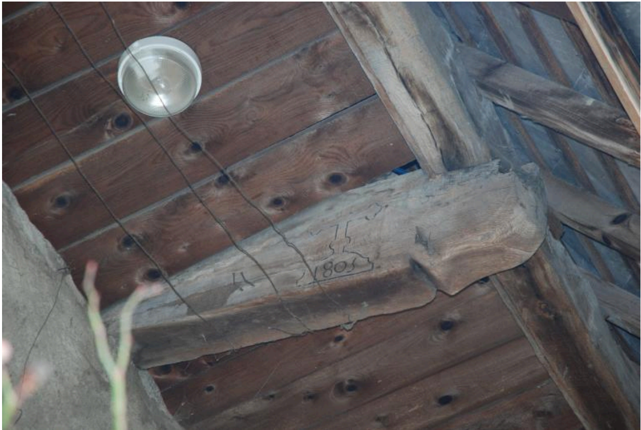
Maison, élévation principale : détail d'un débord d'entrait de charpente daté 1805.
