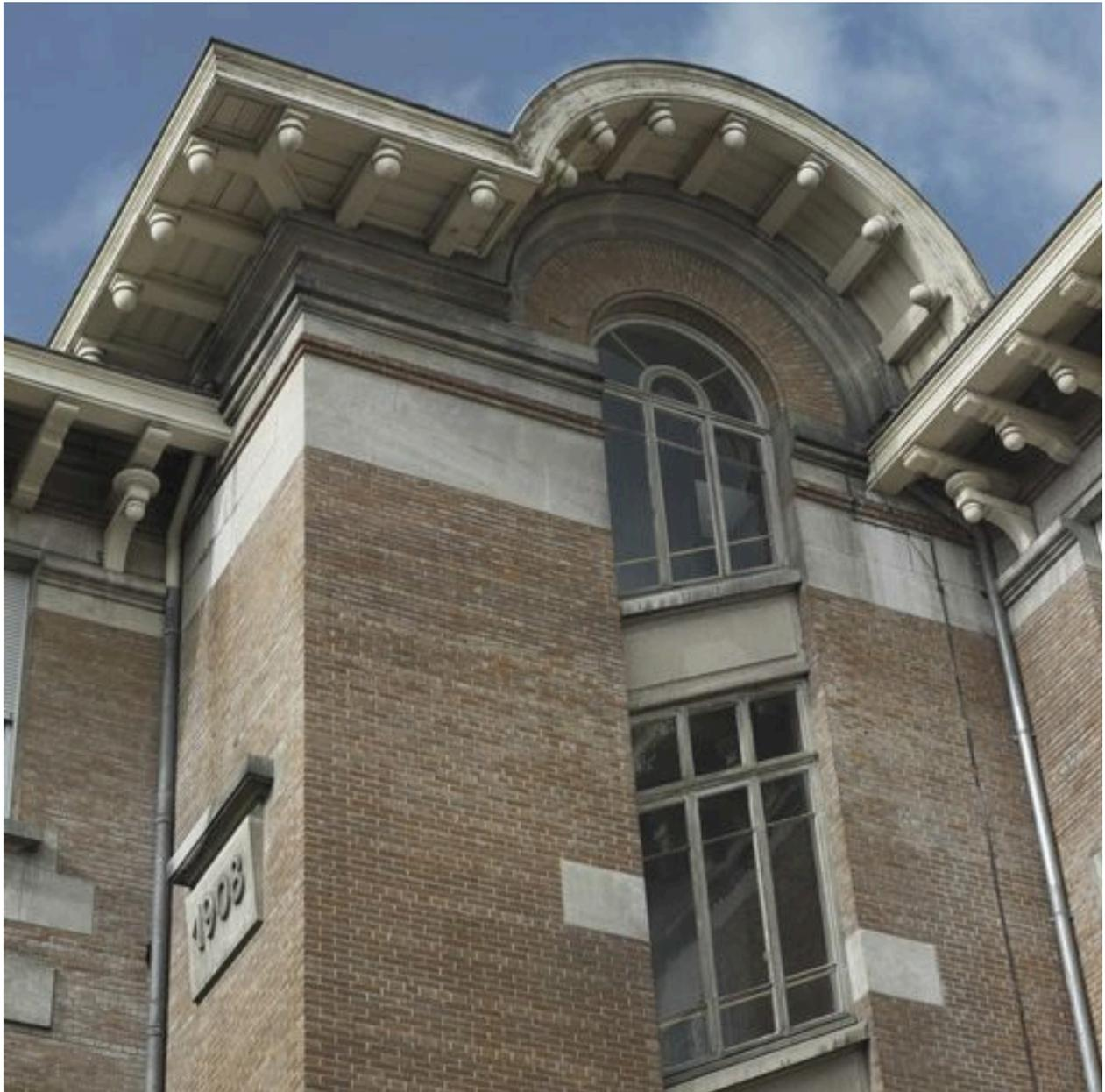
Bâtiment B, façade nord, détail d'élévation de la cage d'escaliers secondaire et amortissements de l'avant-toit
