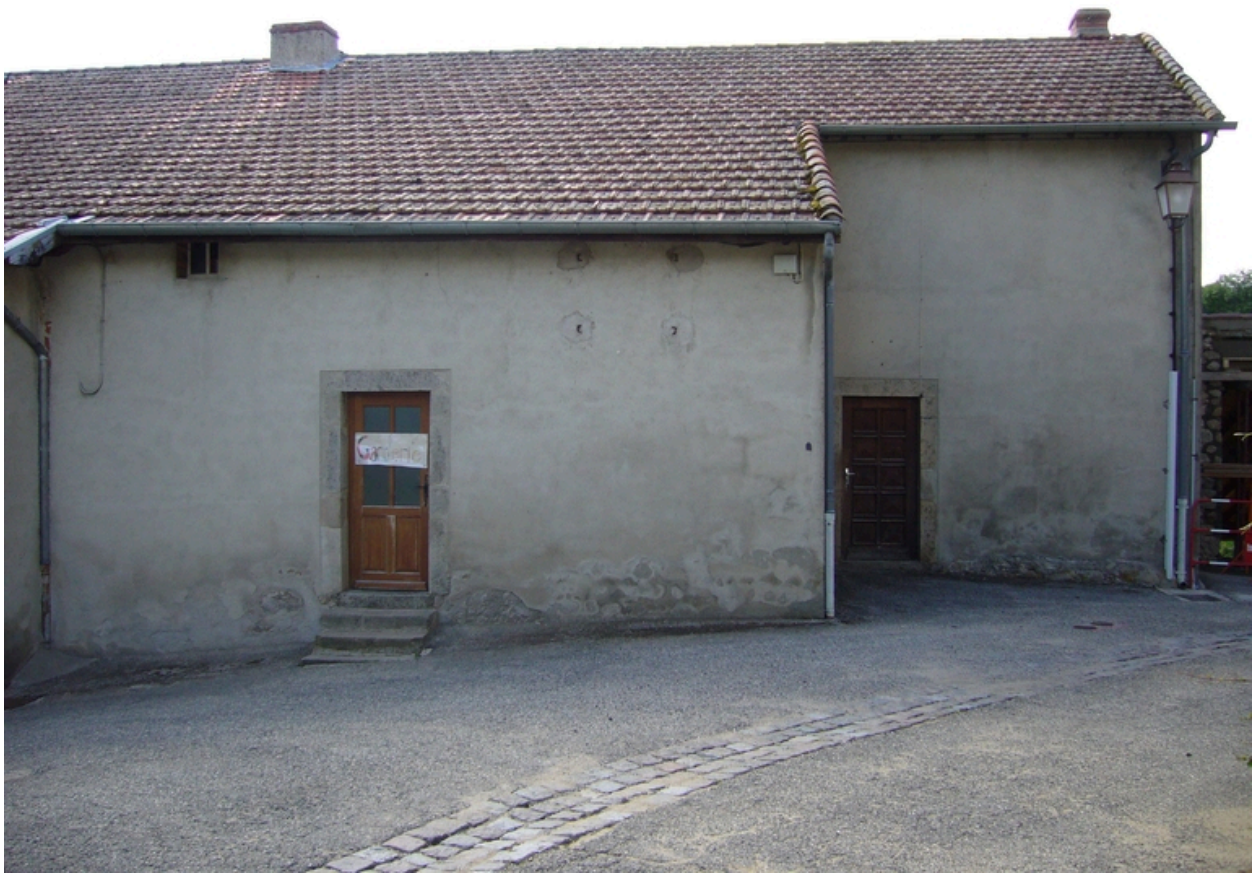
Vue arrière, partie sud-ouest.
