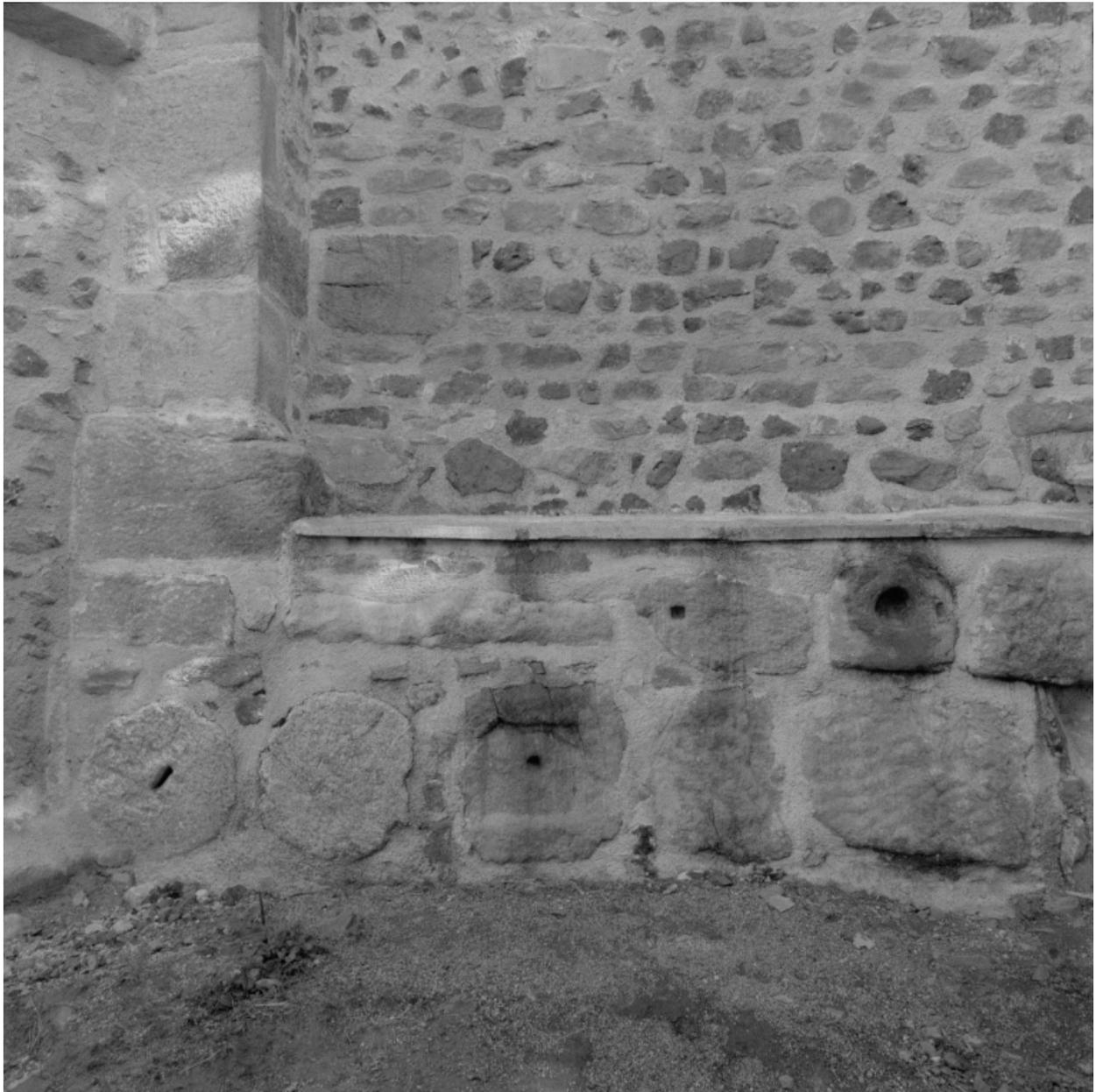
Façade sud : détail de l'appareillage du soubassement, avec des remplois de tambours de colonnes gallo-romaines.
