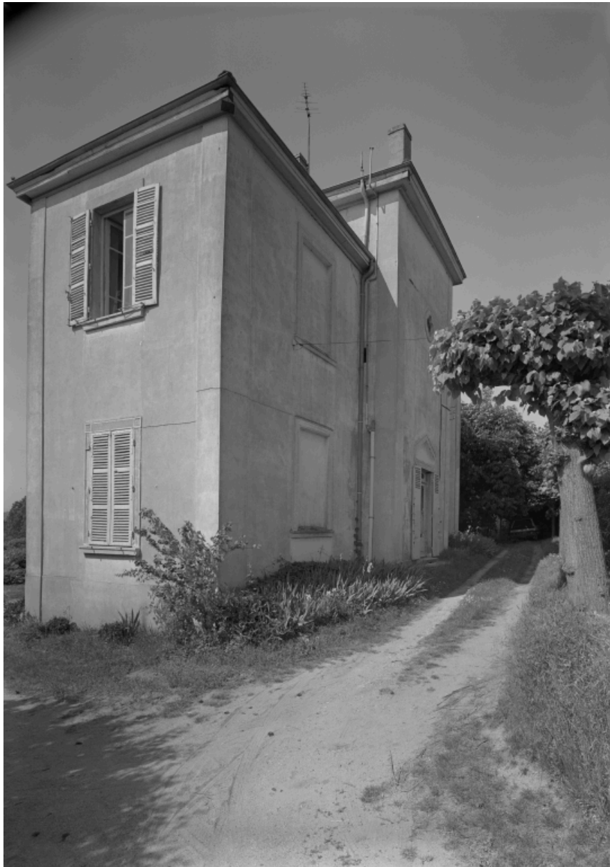
Maison de type V, Saint-Bernard, 381 chemin de la Bruyère, dite villa la Toute belle, élévations postérieure et latérale droite.
