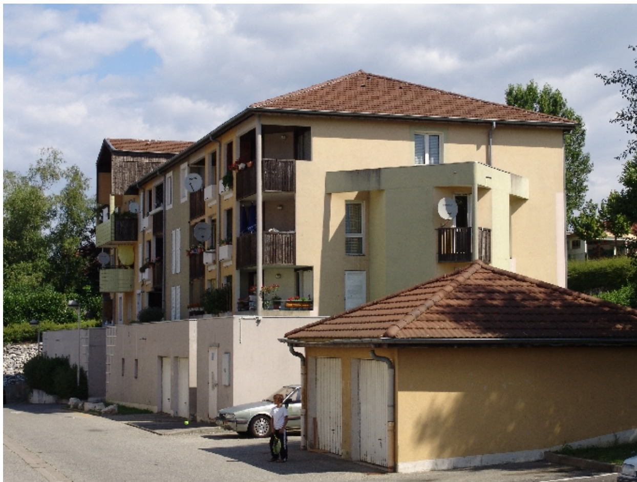
garages et immeuble vus du sud-ouest
