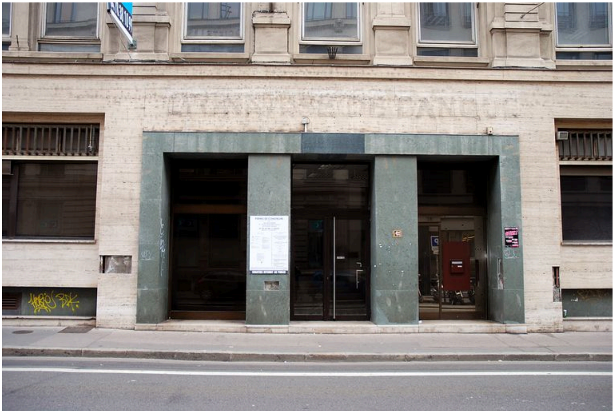
Détail du rez-de-chaussée.
