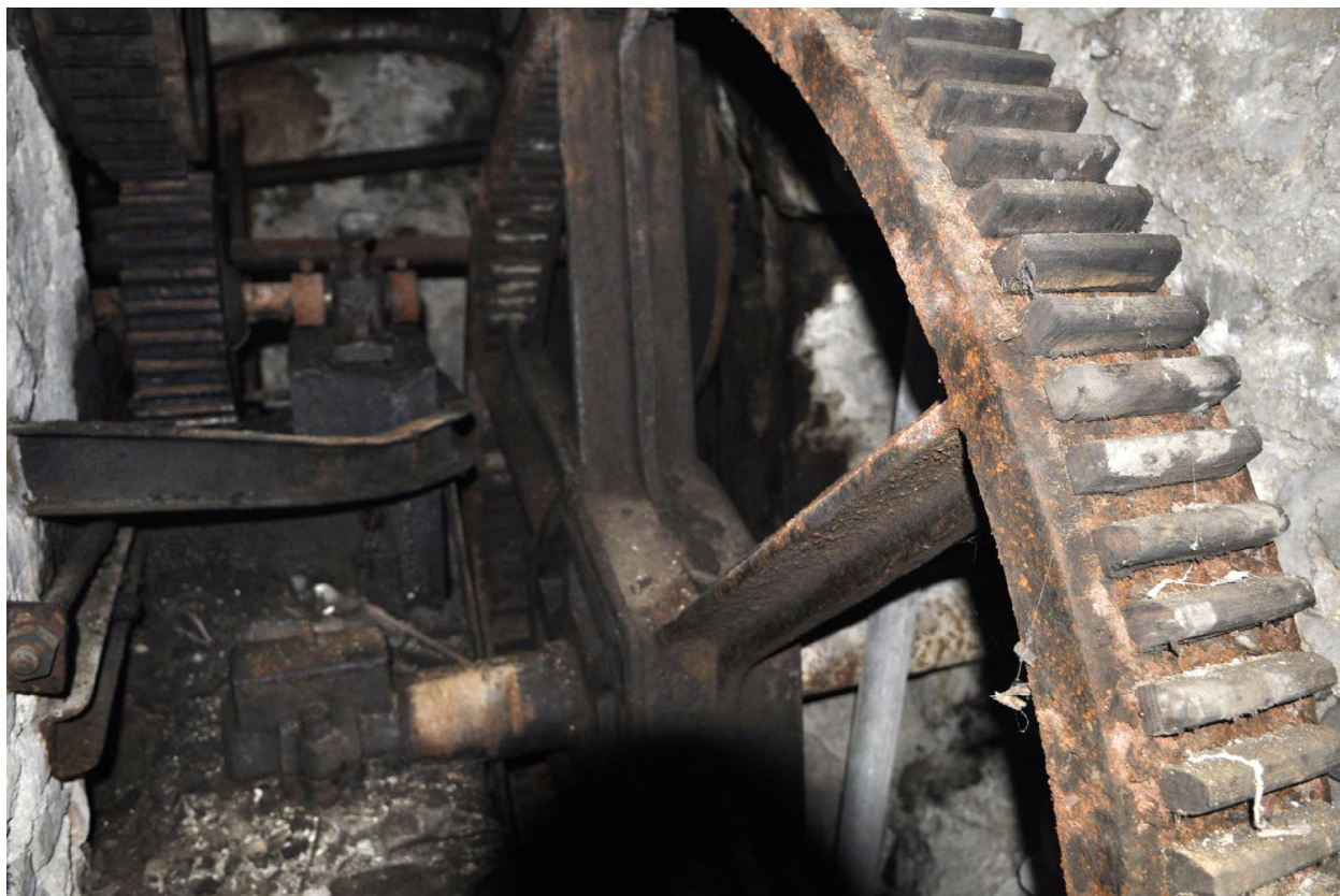
Ancien système hydraulique (vue d'intérieur)
