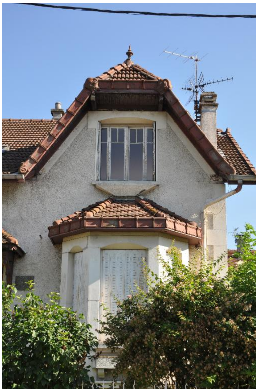
Détail du bow-window et de la lucarne pignon
