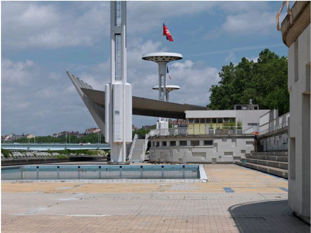
Vue générale du bâtiment d'exploitation depuis le sud (état juin 2012).
